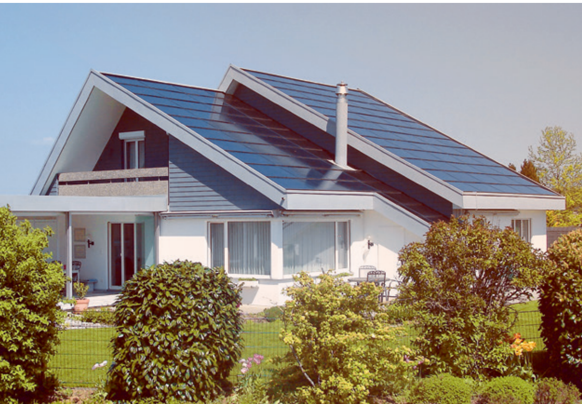
Bei der Sanierung des Einfamilienhauses in Giebenach wurde die Ölheizung durch eine Wärmepumpe ersetzt. Einen Teil des benötigten Stroms produziert neu eine vollflächige, dachintegrierte Photovoltaikanlage. Quelle: EnergieSchweiz
