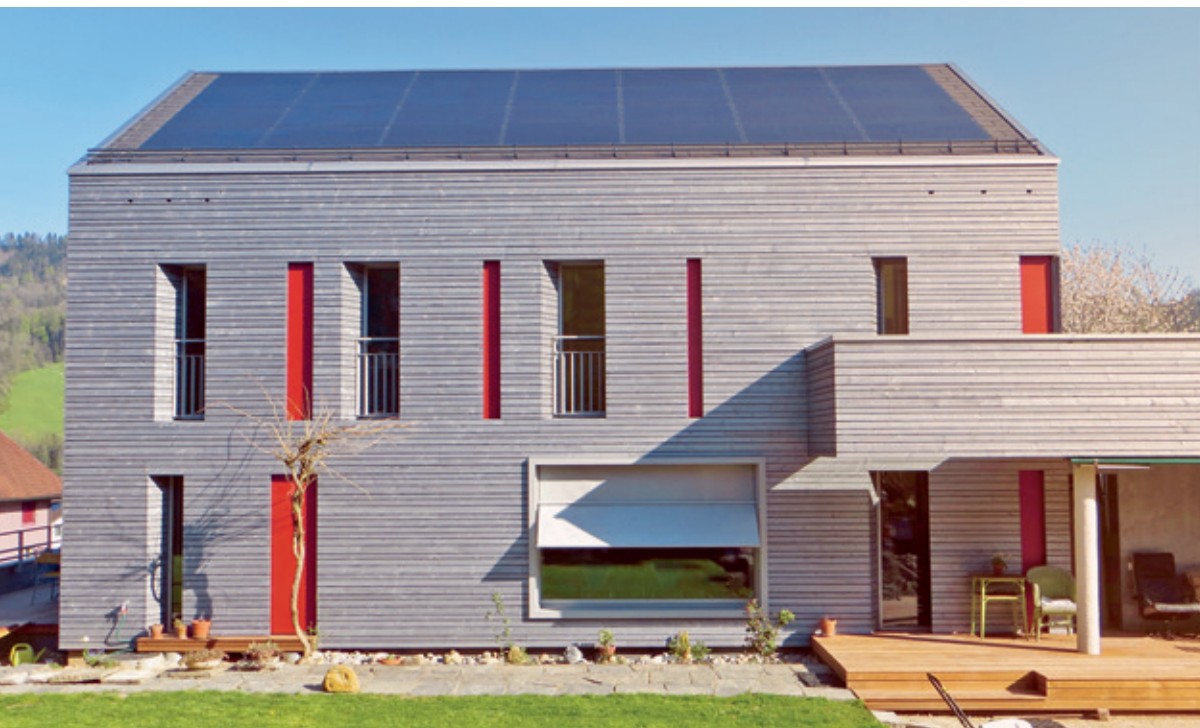
Eine umfassende Sanierung wie bei diesem Einfamilienhaus in Malters ist in der Regel nach 40 bis 50 Jahren nötig. Quelle: EnergieSchweiz
