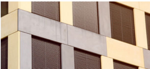
Lamellenstoren können das Tageslicht nicht nur dosieren, sondern durch Schrägstellen der Lamellen bis zu einem gewissen Grad auch lenken.
